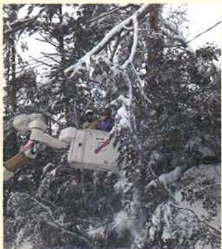
雪の重さで折れた木が電線を直撃。高所作業車を使って障害物を除去
