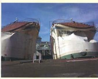
津波の影響で損傷した純水タンク
