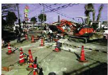
旭原地区整備 (総合雨水排水対策事業)
